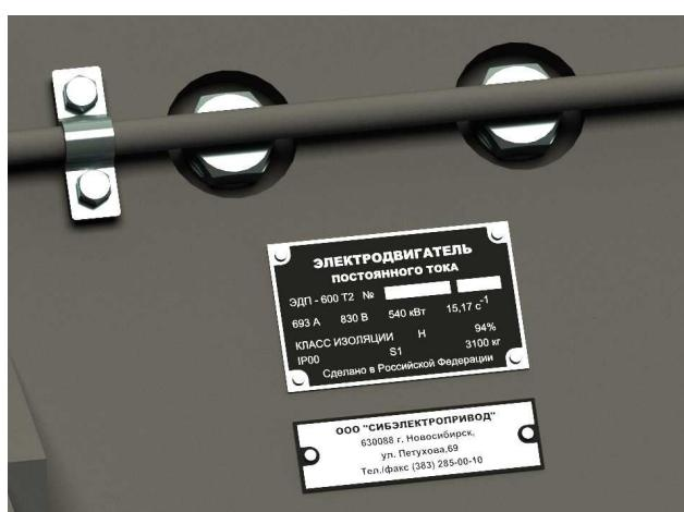
Рисунок 8 – Пример маркировки электродвигателя
